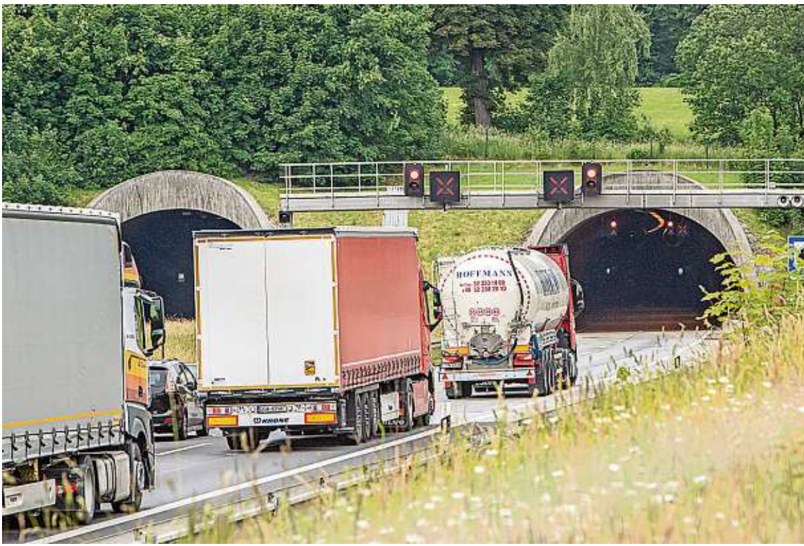
Rückstau wegen einer A-4-Baustelle. Ob es solche Bilder am Tunnel Königshainer Berge dieses Jahr wieder gibt?
